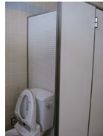
トイレブ ース
