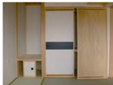
押入れ(戸、棚板、枕板)
