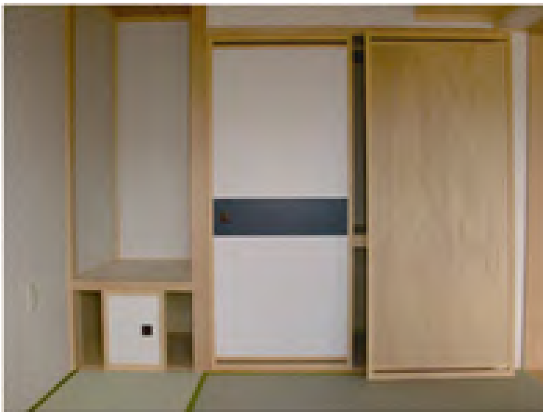
押入れ(戸、棚板、枕板)
